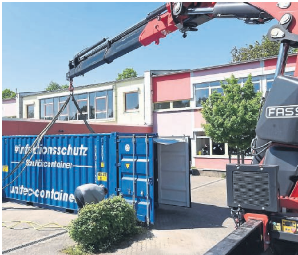
Mit einem Kran hoben die Mitarbeiter der Firma Unitec den blauen Container vom Lastwagen und platzierten ihn auf dem Schulhof der Sälzer-Grundschule. Am Montag soll ein zweiter Sanitärcontainer folgen.
